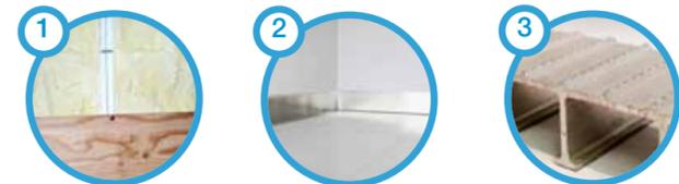
1 ISOLATION À L'URÉTHANE RECOUVERTE DE « PLYWOOD »
